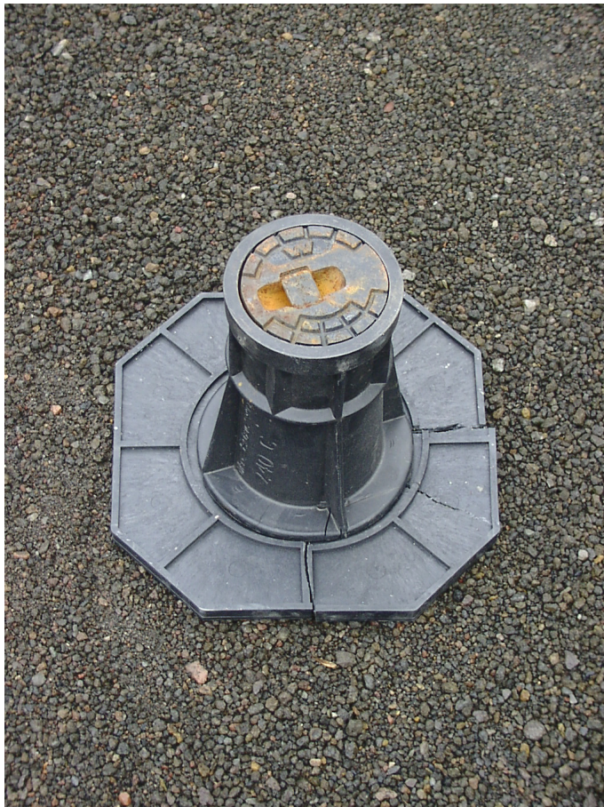
Abbildung 1: Tragplatte Typ 1, 340 x 340 mm mit Straßenkappe DIN 4057/74 nach Prüfung der Bruchlast.
